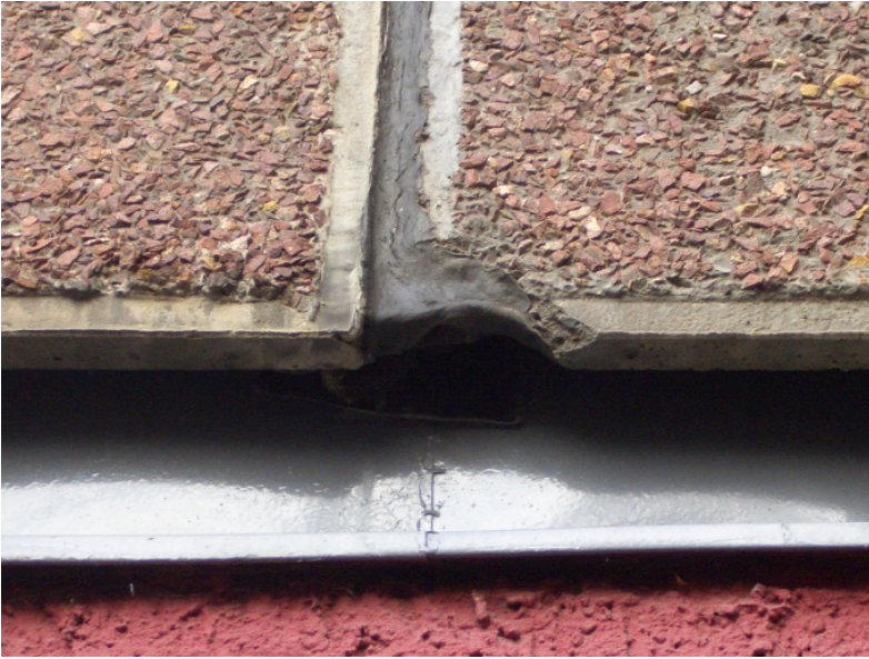
Schwachstelle Plattenfuge
